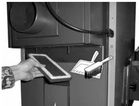
Ilustracja czyszczenia kanału dymowego w tylnej części kotła
