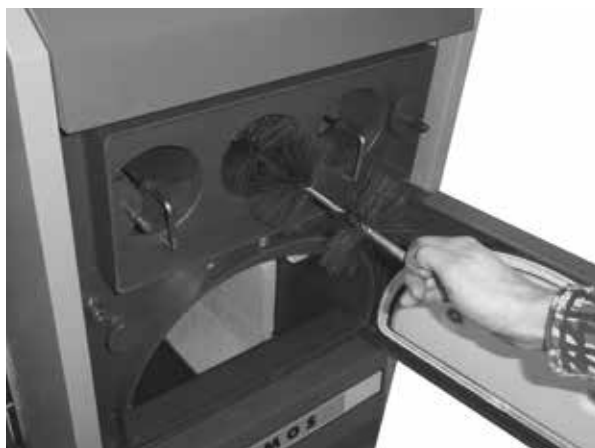
Wyczyszczenie wymiennika (sit paleniskowych) włożoną szczotką (dla kotłów D20P, D30P, D40P i D50P)
