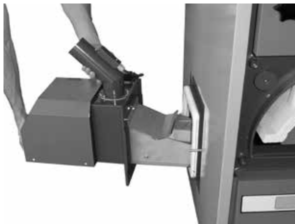
Wyjęcie palnika z kotła podczas corocznej konserwacji i czyszczenia
