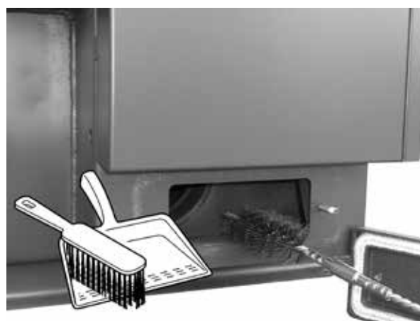
Otwarte dolne wieko oczyszczania na kanale spalinowym
