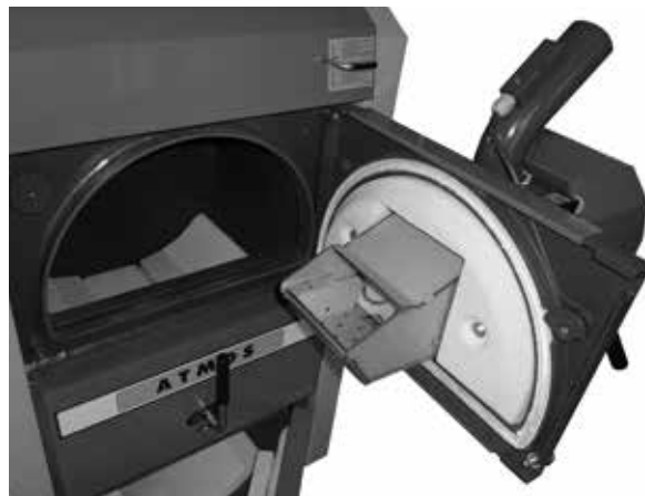
Otwarte drzwi górne kotła przy czyszczeniu komory spalania palnika
