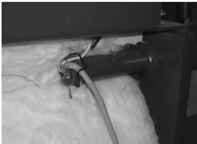
Rys. 15 – Widok czujnika temperatury wody TK podłączonego do kotła- DCxxSP(EP), lub kotłów z palnikiem w górnych drzwiczkach- DCxx- S(X), CxxS, ACxxS, DCxxRS
