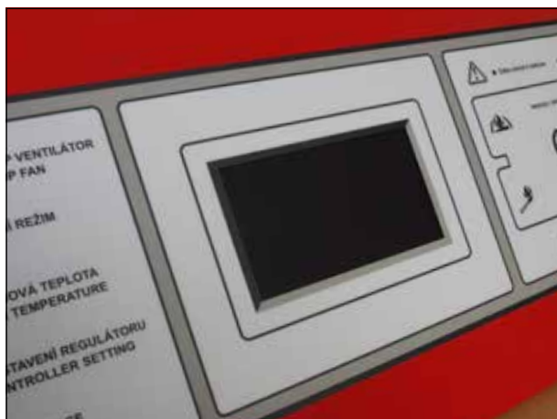
Regulator w panelu przyrządowym kotła
